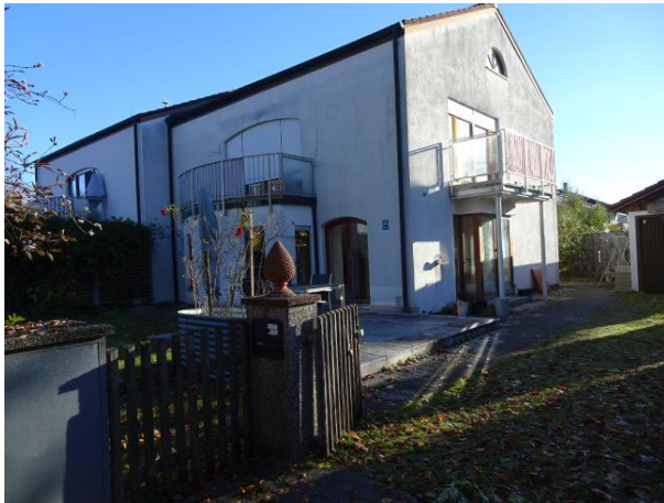
Ansicht von der Frühlingsstraße
