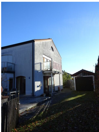
Ansicht von der Frühlingsstraße mit Garagenzufahrt
