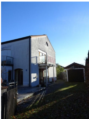
Ansicht von der Frühlingsstraße mit Garagenzufahrt
