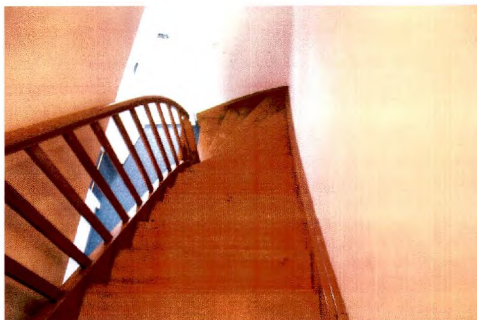
Treppe – EG. – OG.
