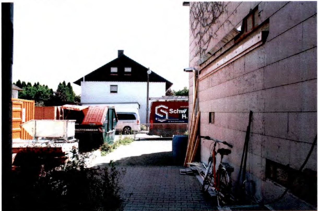
Einfahrt – von Westen -> Richtung Osten
