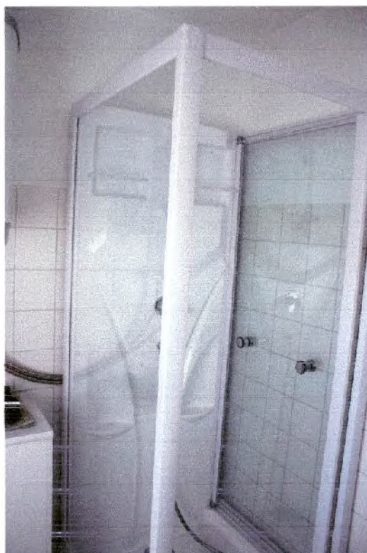
Teilansicht – Bad OG. Dusche - Fertigbau
