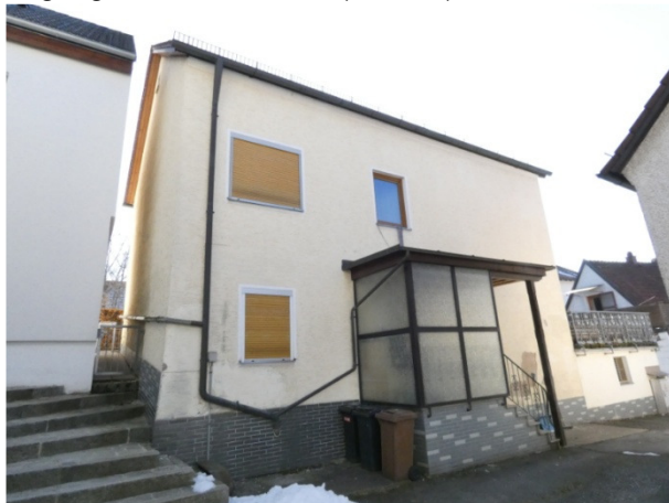
Eingangsseite Wohnhaus (Norden)
