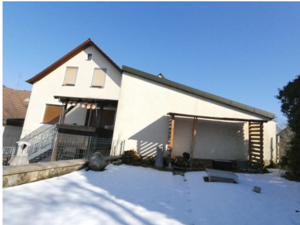
Ansicht von Westen mit dem Anbau
