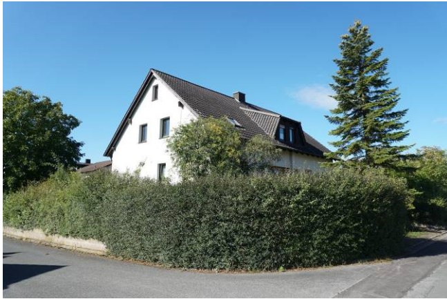
Blick von Osten auf das Zweifamilienhaus mit Wohnungseigentum Nr. 1 im Erdgeschoss
