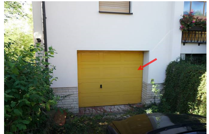
Blick auf die Kellergarage im Zweifamilienhaus als Bestandteil des Wohnungseigentums Nr. 1
