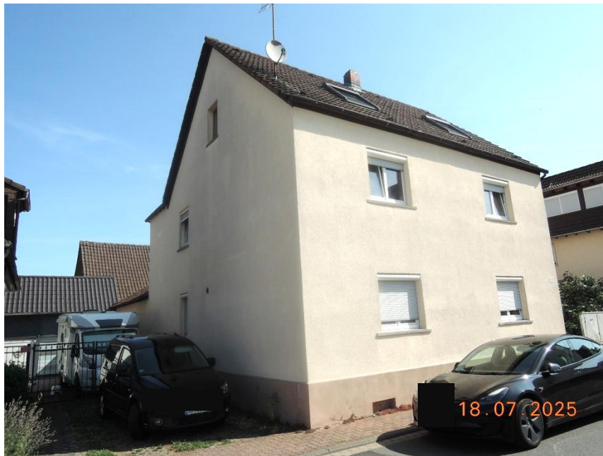
Bild 2: Straßenansicht aus südwestlicher Richtung
