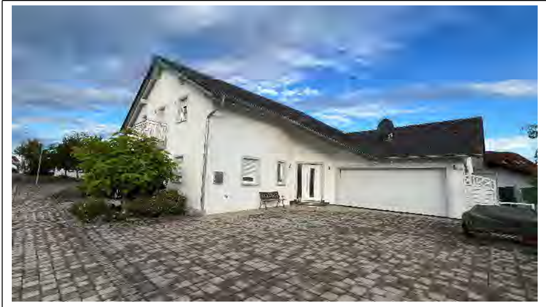
Foto 5: Ansicht von Osten
