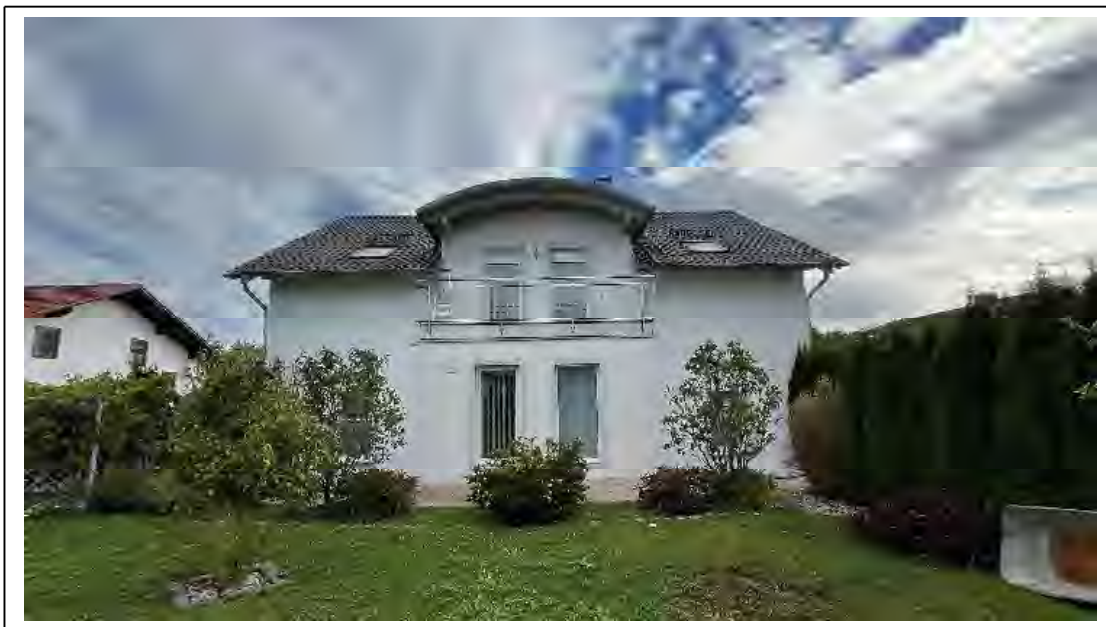
Foto 4: Ansicht von Westen
