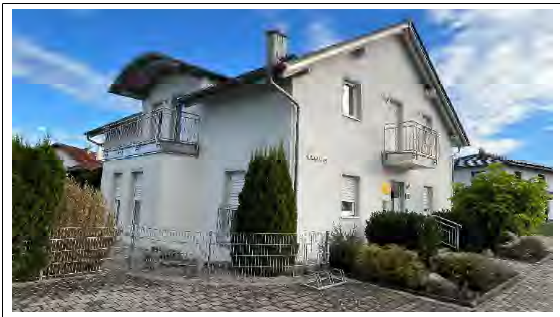
Foto 2: Ansicht von Südwesten
