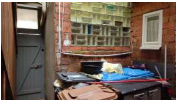
Westfassade Haus Nr. 6
