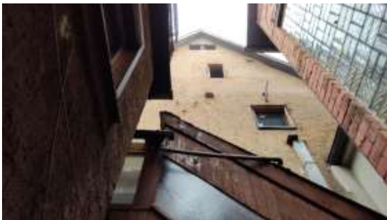
Südfassade Haus Nr. 4 mit Außentreppe EG – 1.OG
