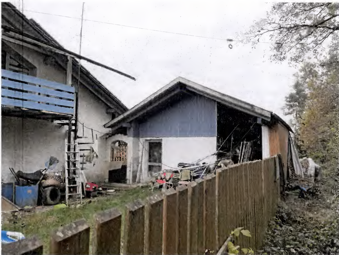
Ansicht von Westen auf die Garage
