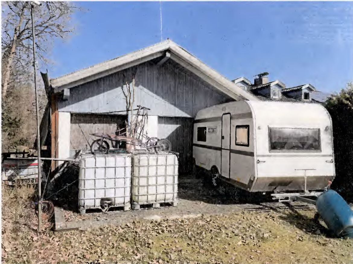
Ansicht von Süden der Garage
