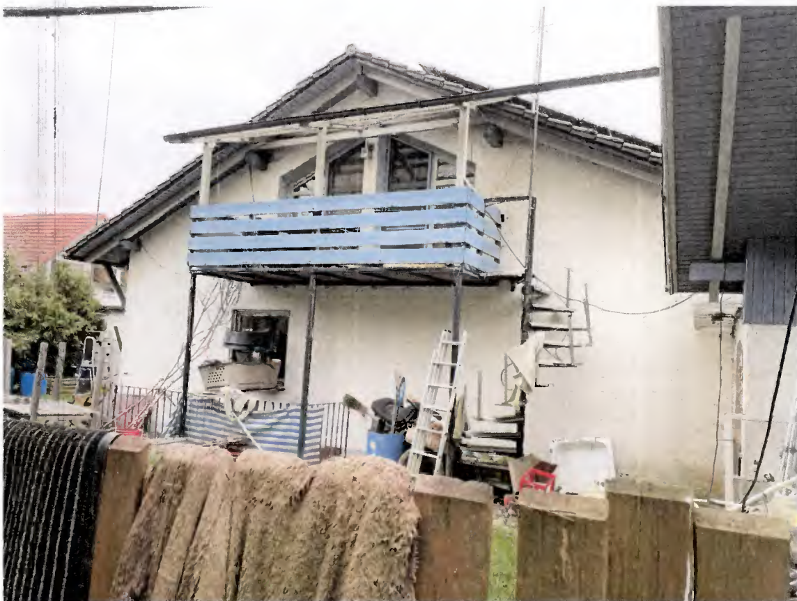
Ansicht von Westen (Waldseite)
