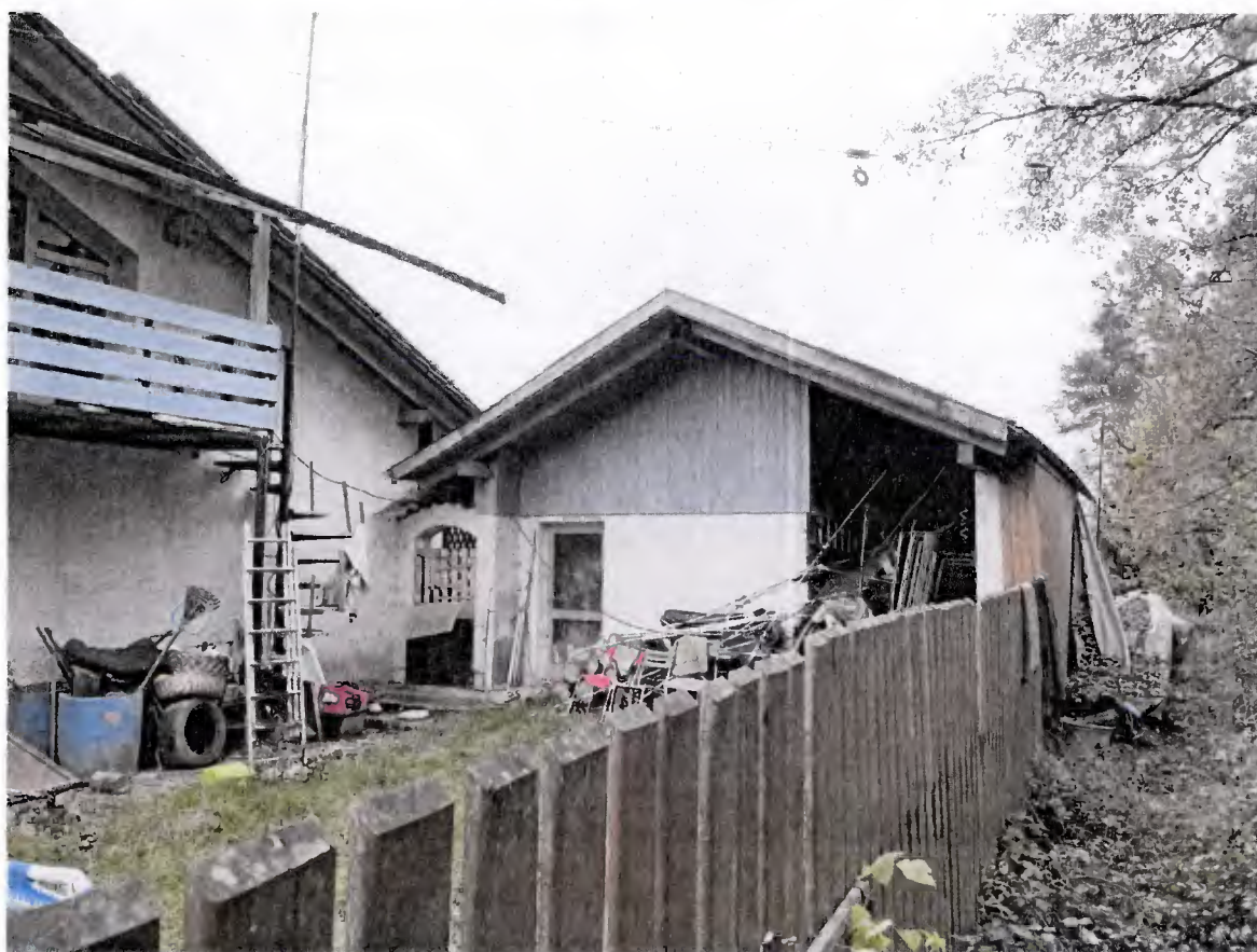
Ansicht von Westen auf die Garage
