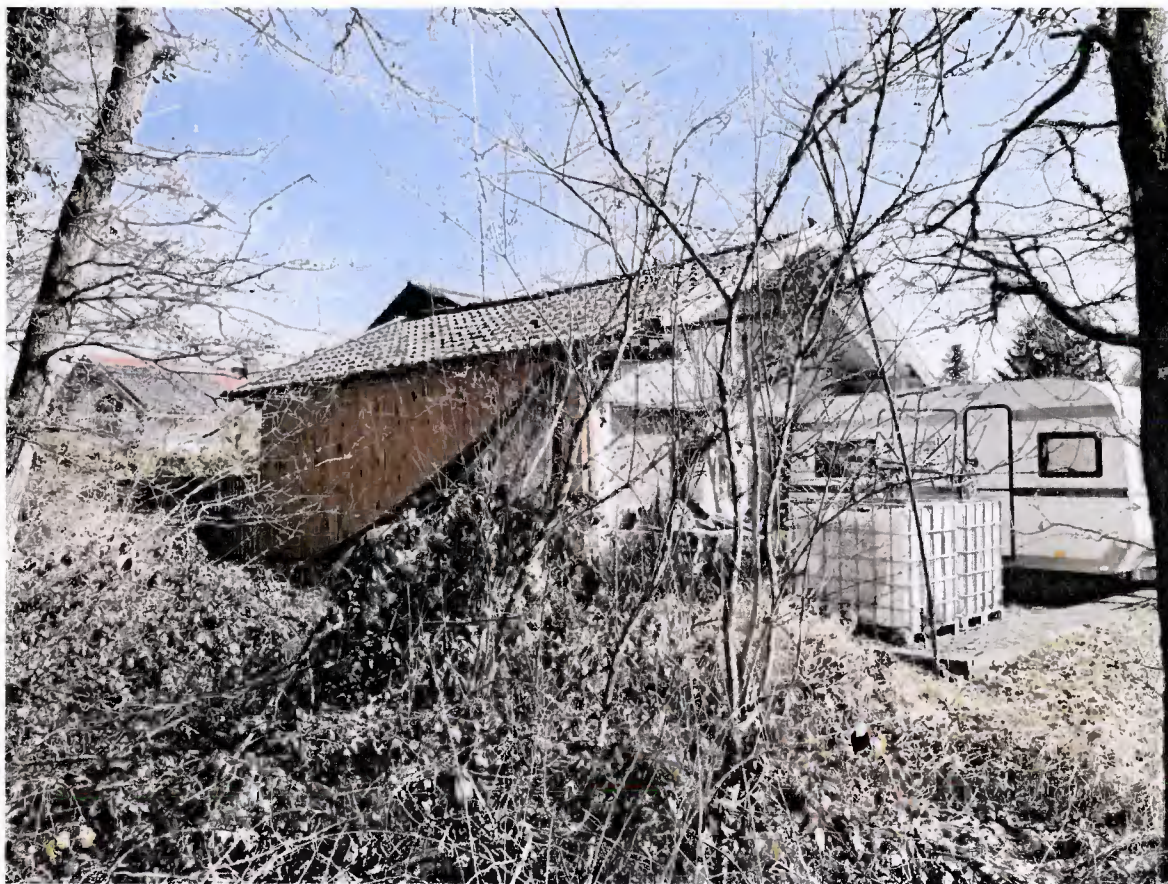
Ansicht von Südwesten auf die Garage
