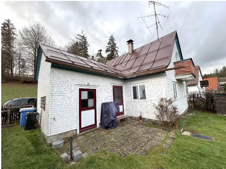
Bild 5 – Anbau und Wohnhaus von Süden und Osten
