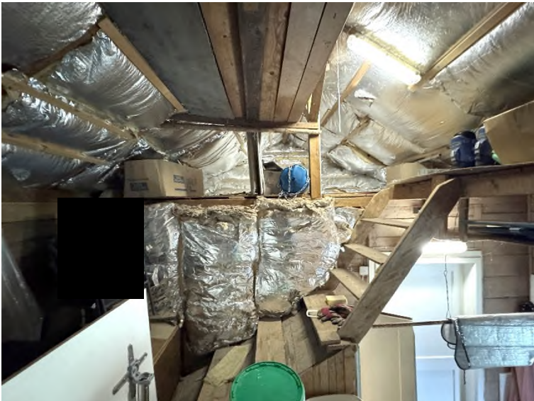
Bild 11 – Dachboden im Anbau
