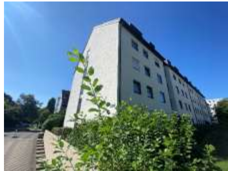
Bewertungsobjekt (Ansicht von Nordosten)
