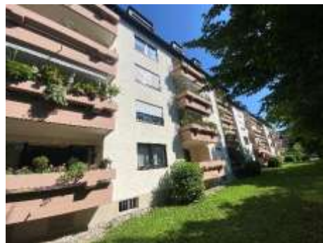
Bewertungsobjekt (Ansicht von Südwesten)
