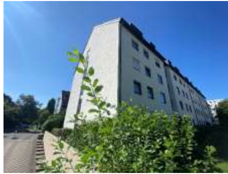
Bewertungsobjekt (Ansicht von Nordosten)
