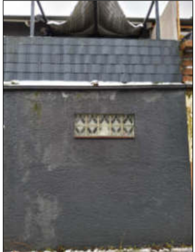
Foto 9: Nordfassade (Teilbereich Eingang; 1. OG Balkon)
