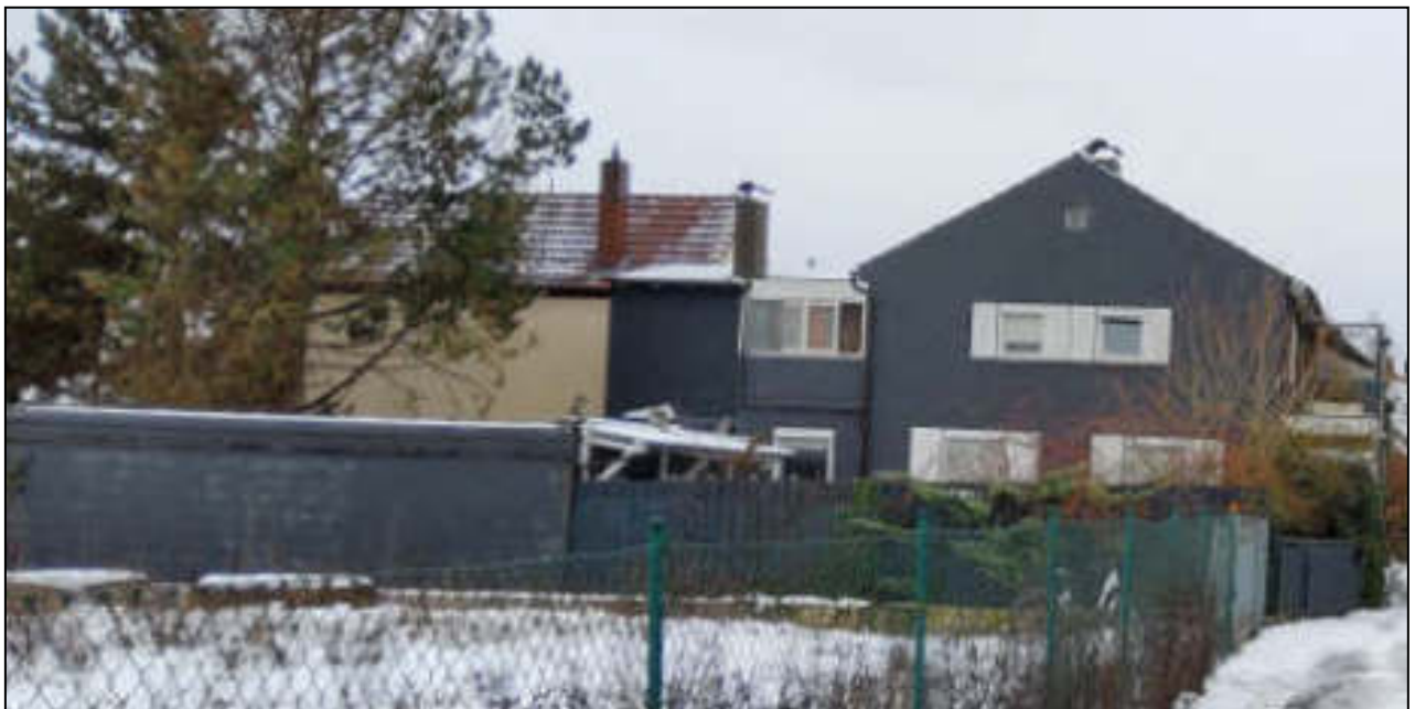
Foto 4: Ostansicht (Garage, Einfriedung, Wohngebäude)
