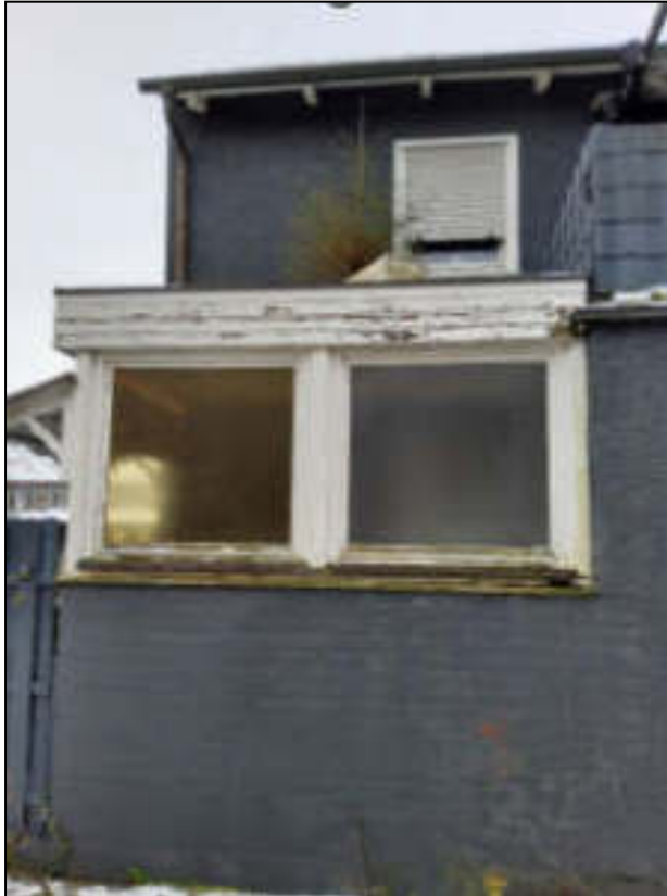
Foto 8: Nordfassade (Teilbereich überdachter, offener Zugang)
