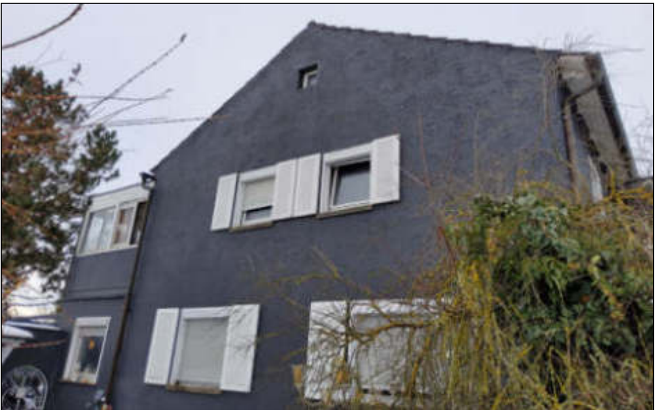
Foto 10: Ostfassade (Giebel; Anbau im rückseitigen Bereich; 1. OG überdachter Balkon)
