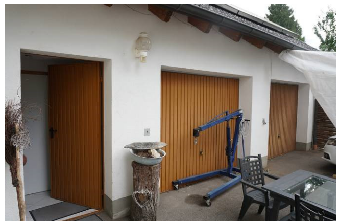
Blick von Südwesten auf das Bewertungsobjekt Nebengebäude
