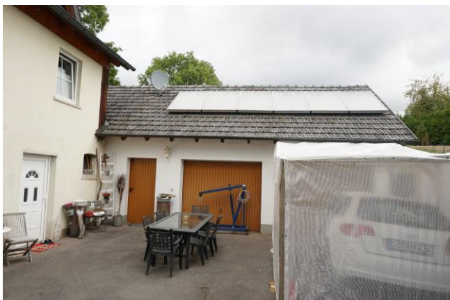
Blick von Süden auf das Bewertungsobjekt Nebengebäude
