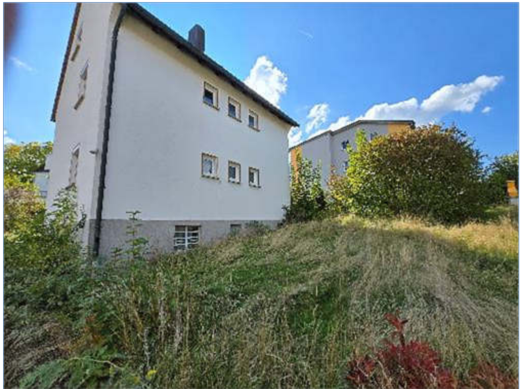
Bild 5 Pos. 01 Wohnhaus, Nordseite
