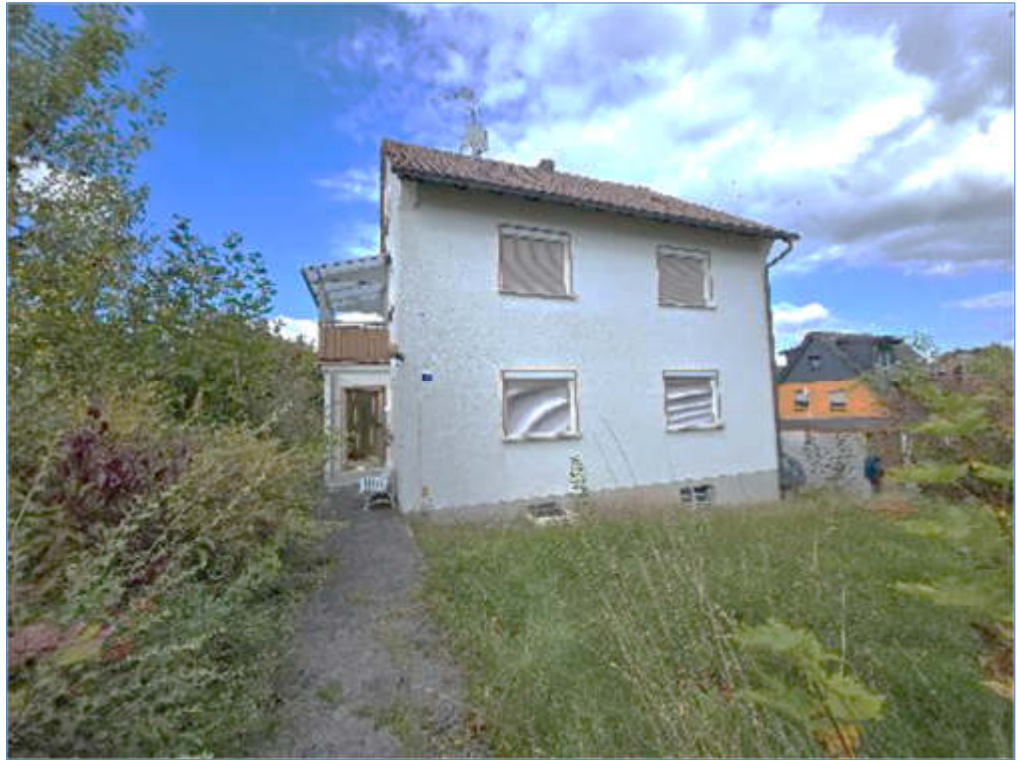
Bild 1 Pos. 01 Wohnhaus Südseite
