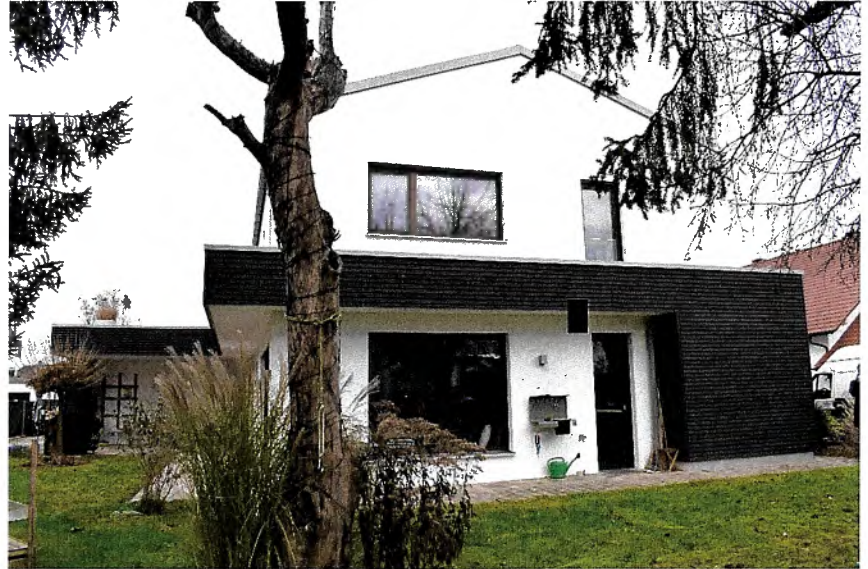
Ansicht des Wohnhauses aus südlicher Richtung
