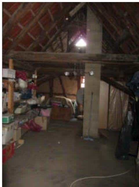
Bild 20: Nicht ausgebautes Dachgeschoss
