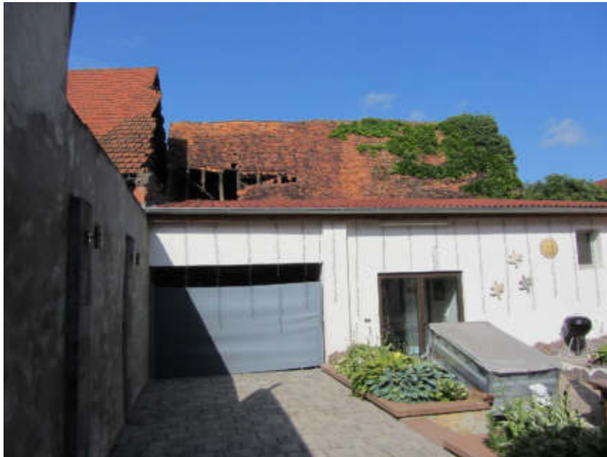
Bild 7: Ansicht Nebengebäude, Hofseite
