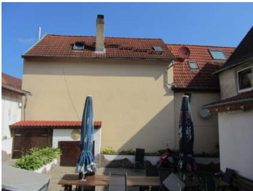
Bild 8: Ansicht Nachbargebäude, Hofseite
