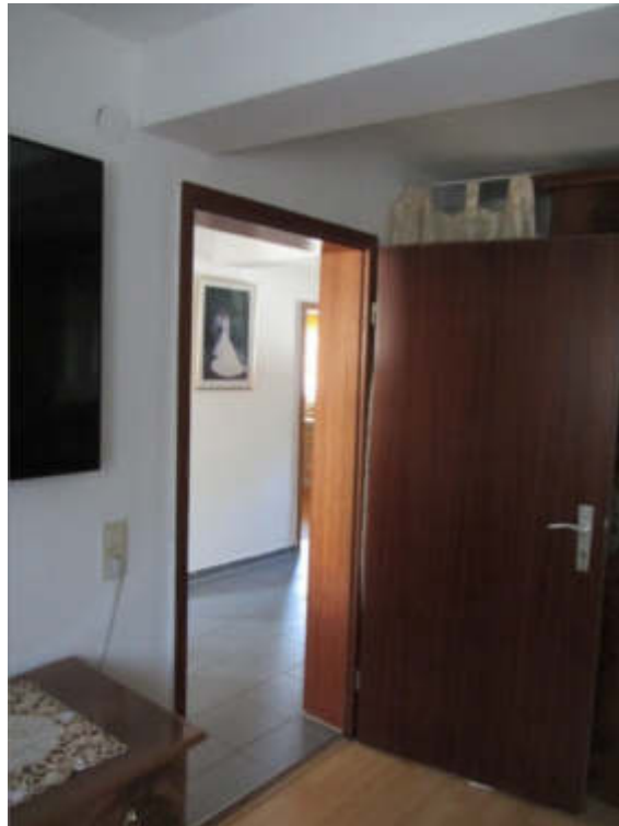
Bild 33: 1. OG: Zustand Innentüren
