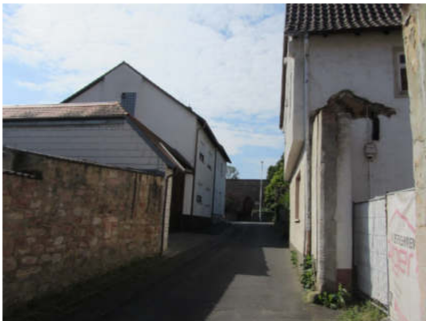
Bild 56: Nachbarbebauung im Straßenverlauf
