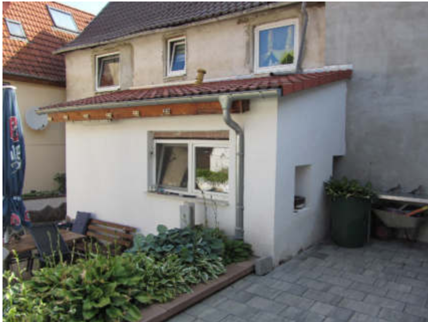
Bild 5: Ansicht Anbau (ehem. Wintergarten)
