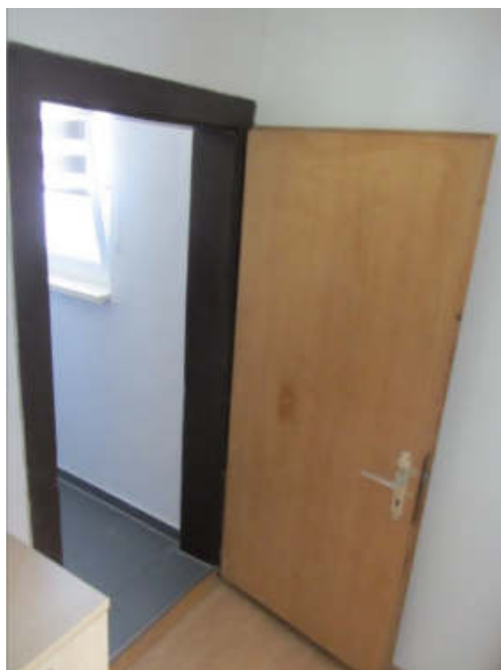
Bild 40: 1. OG: Zustand Innentüren
