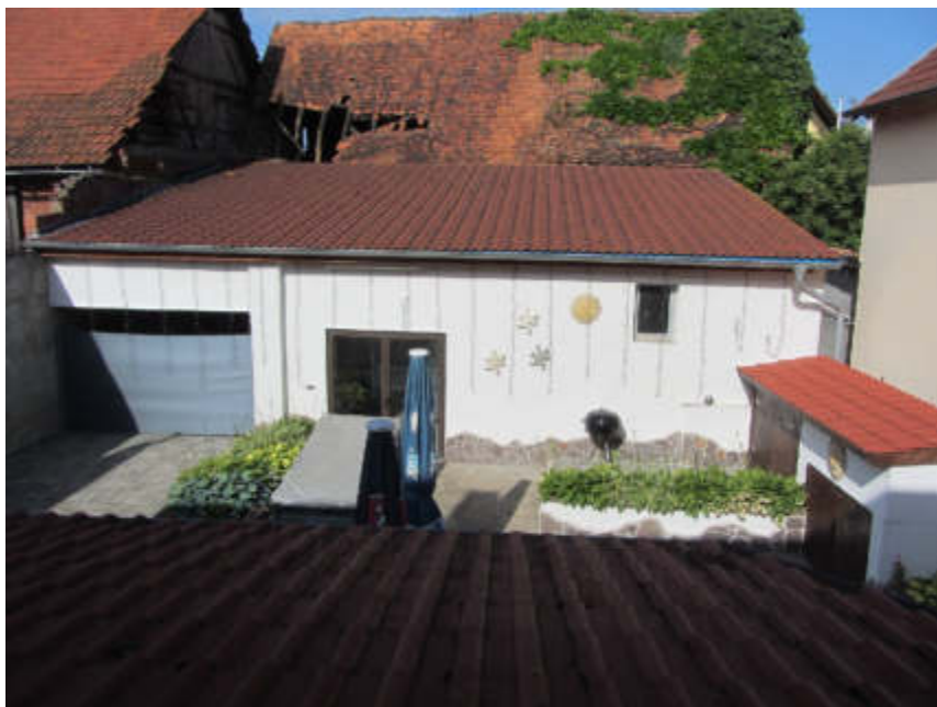
Bild 6: Ansicht Nebengebäude, Hofseite
