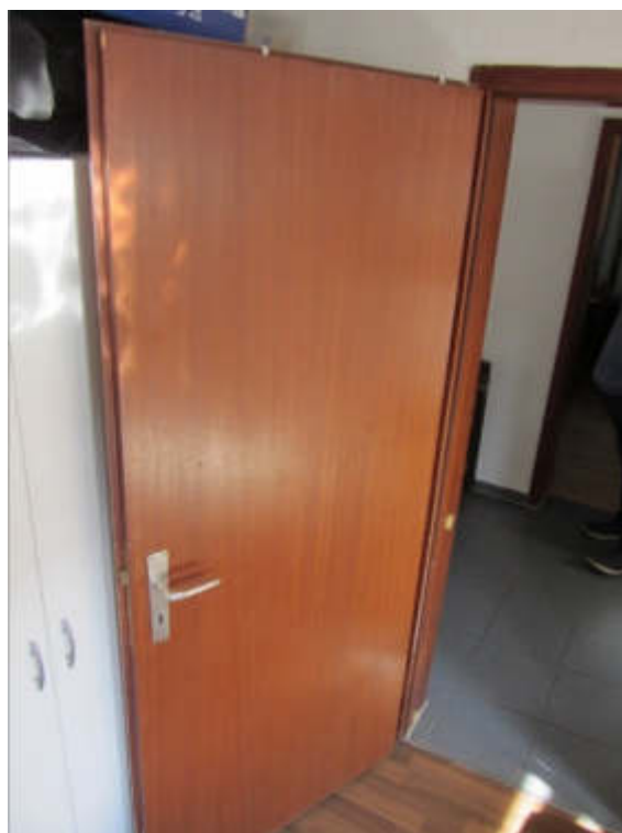
Bild 28: 1. OG: Zustand Innentüren
