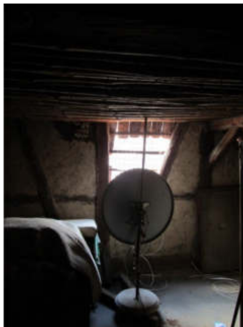
Bild 22: Nicht ausgebautes Dachgeschoss
