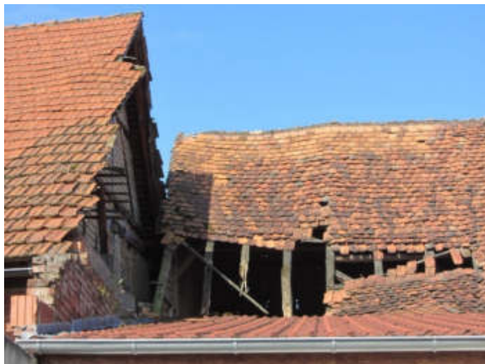
Bild 16: Zustand der angrenzenden Nachbarbebauung
