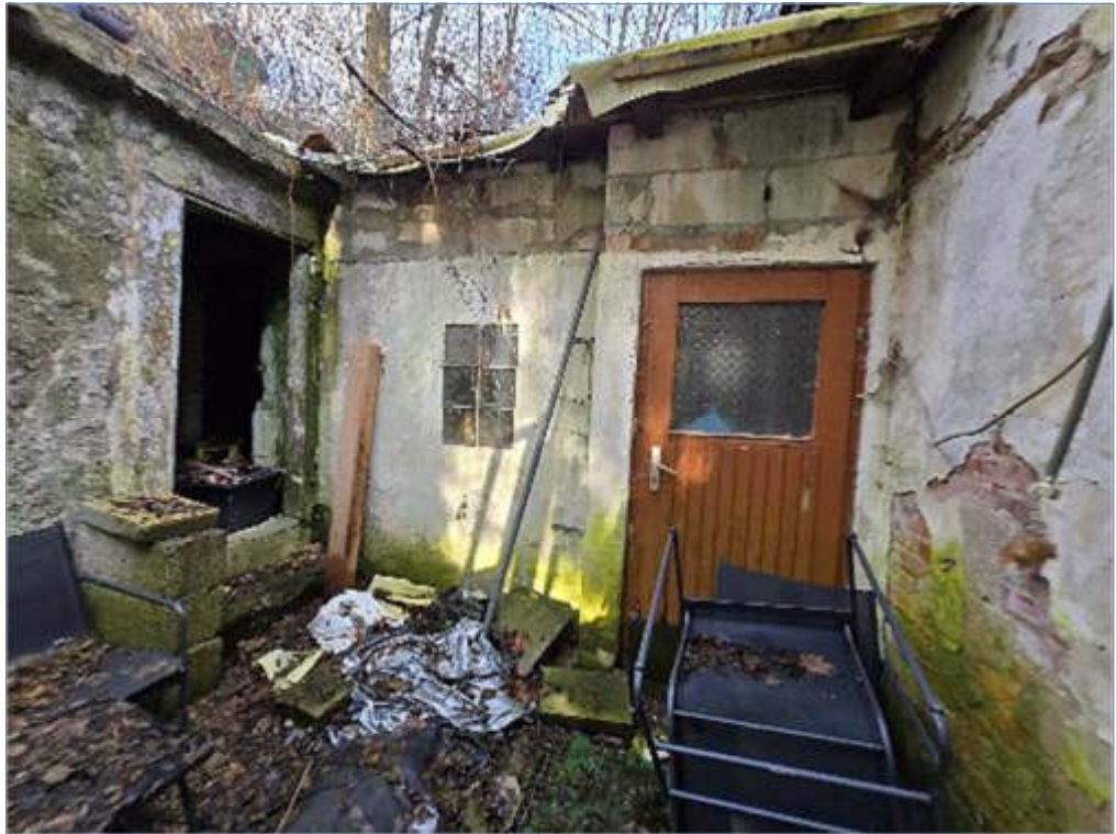
Bild 8 Pos. 01 Wohnhaus, Abstellraum Mansarde, außen Südseite
