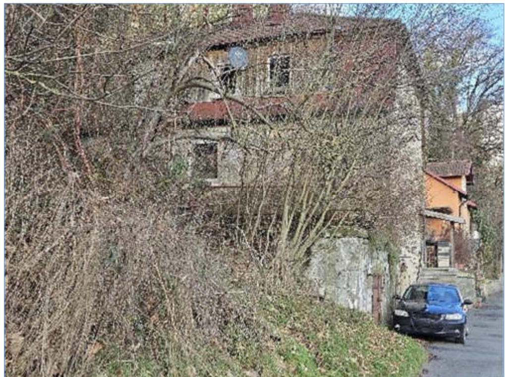
Bild 2 Pos. 01 Wohnhaus, Südseite
