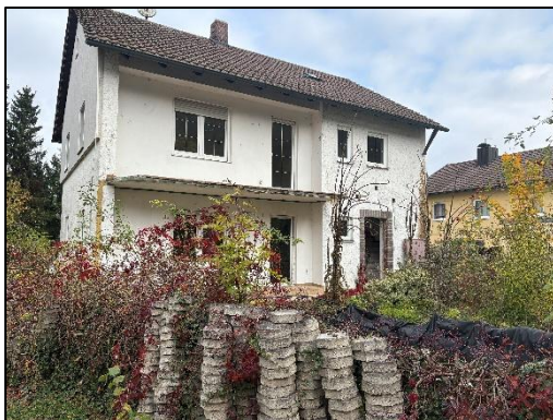
Ansicht Straßenseite (Südseite)
