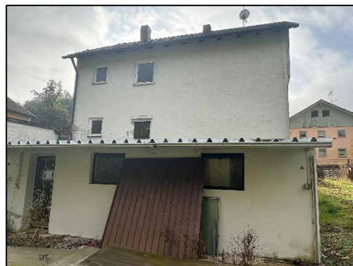
Ansicht Rückseite (Nordseite)
