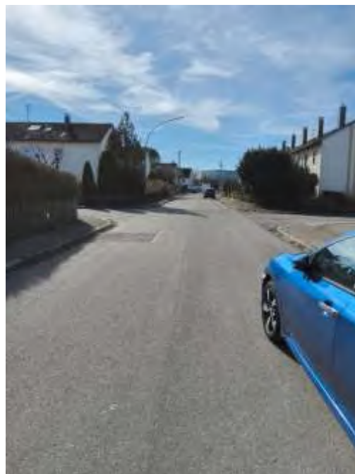
Saubsdorfer Straße ortseinwärts
