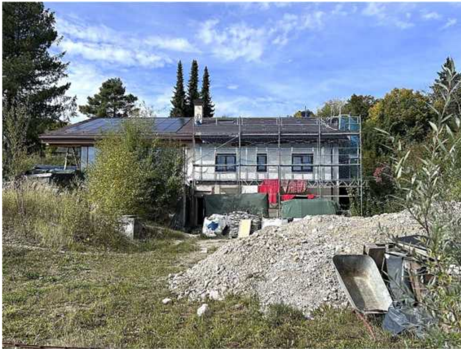
Ansicht aus Richtung Südosten
