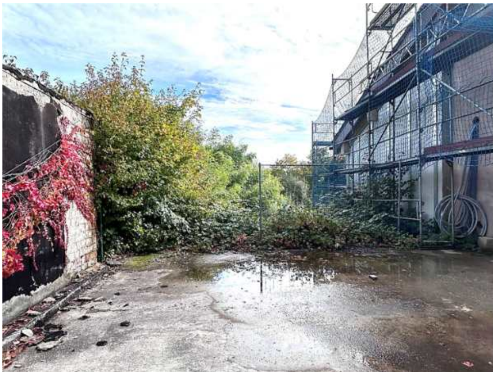
Ansicht aus Richtung Westen / Aufsicht Unterkellerung geplanter Garage
