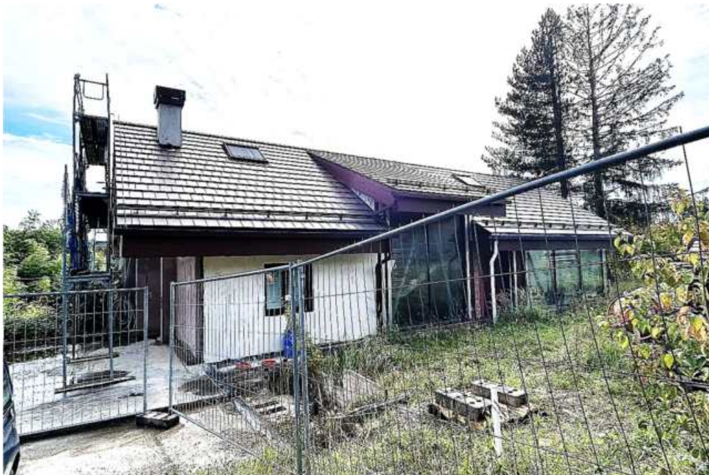
Ansicht aus Richtung Nordwesten
