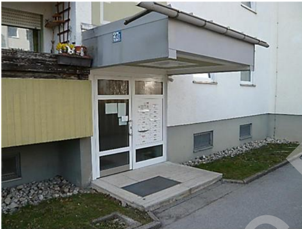
Hauseingang v. Südosten
