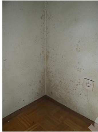
Wohnzimmer, Kältebrücke/Schimmelbefall
