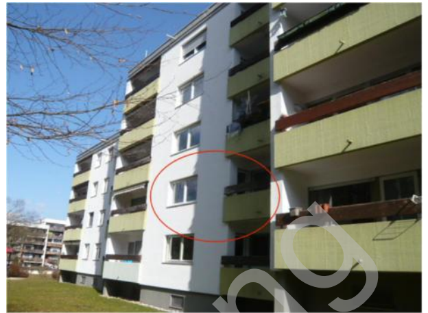
Ansicht v. Südwesten
