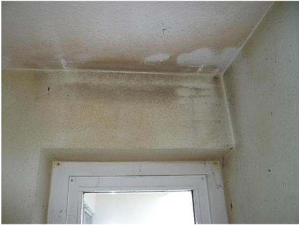
Wohnzimmer, Kältebrücke/Schimmelbefall
