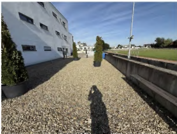
Steingarten Gemeinschaftseigentum Blick Richtung Westen entlang nördlicher Grundstücksgrenze
