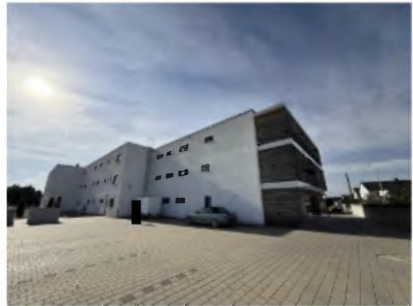
Wohn- und Geschäftshaus Gemeinschaftseigentum Nordansicht
