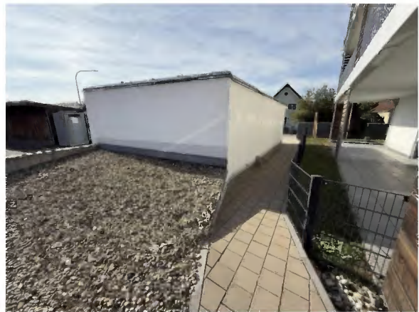
Einfahrt Tiefgarage Gemeinschaftseigentum Nordwestansicht
