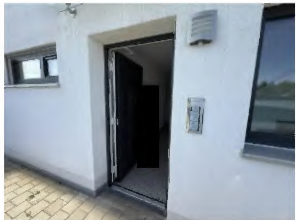
Wohn- und Geschäftshaus Gemeinschaftseigentum Eingang
