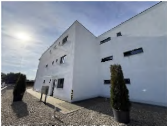
Wohn- und Geschäftshaus Gemeinschaftseigentum Nordansicht
