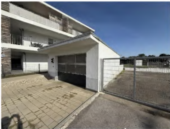
Einfahrt Tiefgarage Gemeinschaftseigentum Südostansicht
