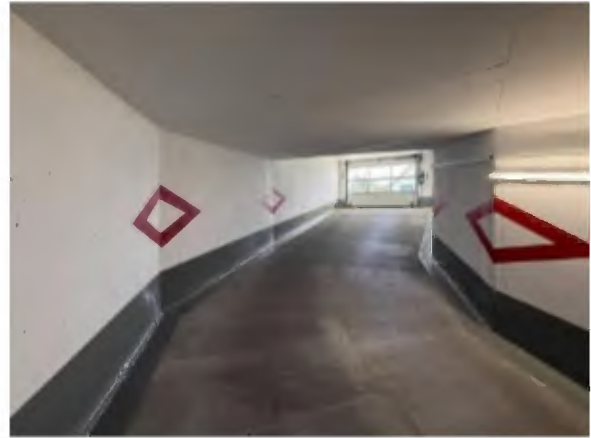
Wohn- und Geschäftshaus Kellergeschoss Gemeinschaftseigentum Zufahrt Tiefgarage
