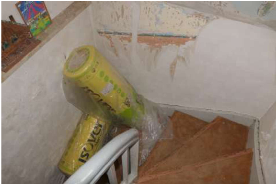
Bild 18: Geschosstreppe zwischen EG und DG
