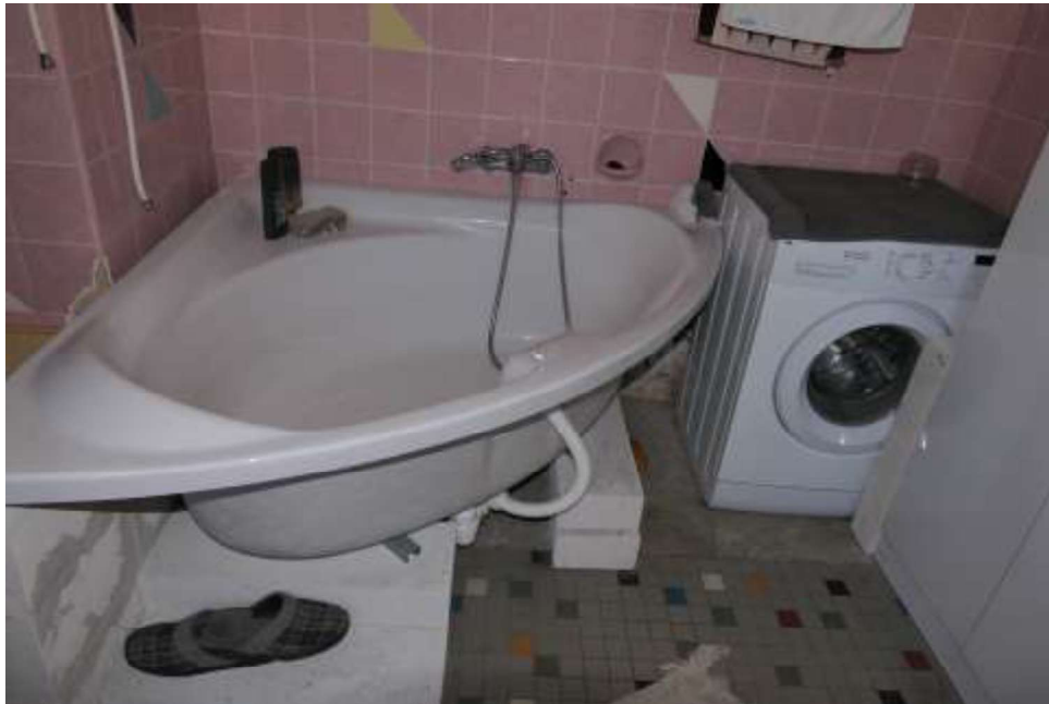
Bild 7: Bad im Kellerbereich des Altbaues
