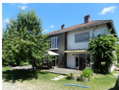
Wohnhaus (BK 1), Ansicht Südwestfassade
