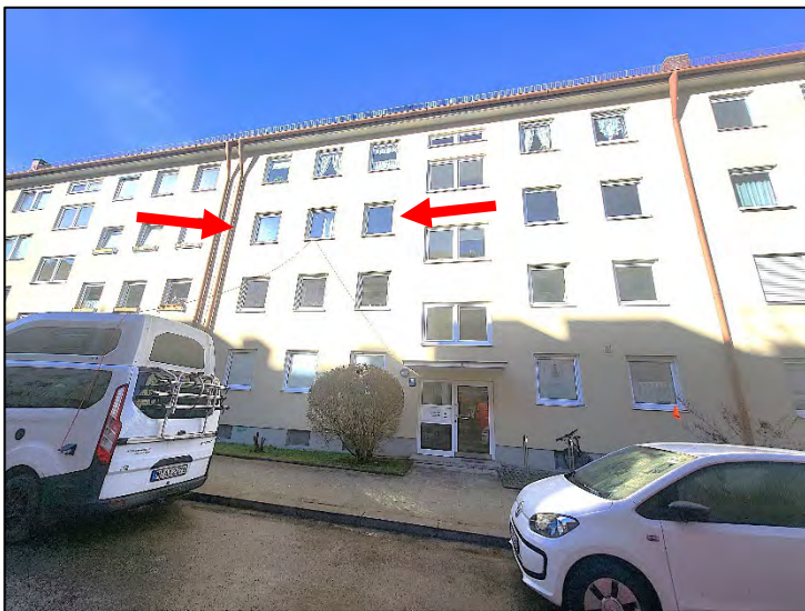
Blick auf das Mehrfamilienhaus Schanzenbachstraße 10; die ge- genständliche ETW Nr. 66 befin- det sich im 2. OG (siehe Pfeile)
