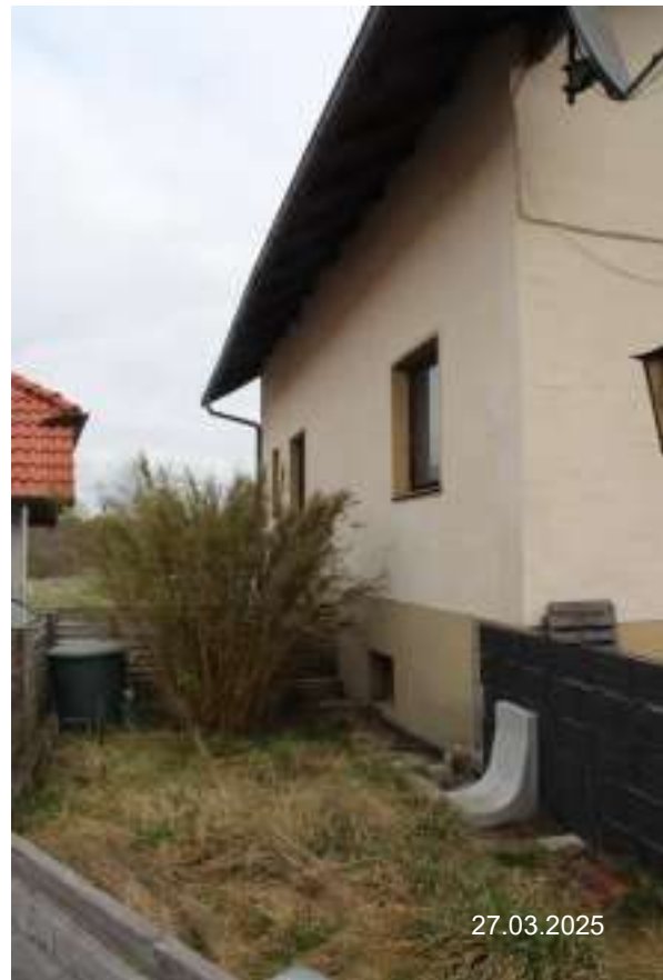
Bild 7: Ansicht Westseite Wohnhaus von Süden
