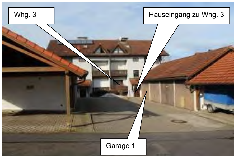
Bild 1: Ansicht Wohnanlage Kellerbergstr. 12,/ Bayerbach von Os- ten (Kellerbergstr.)
