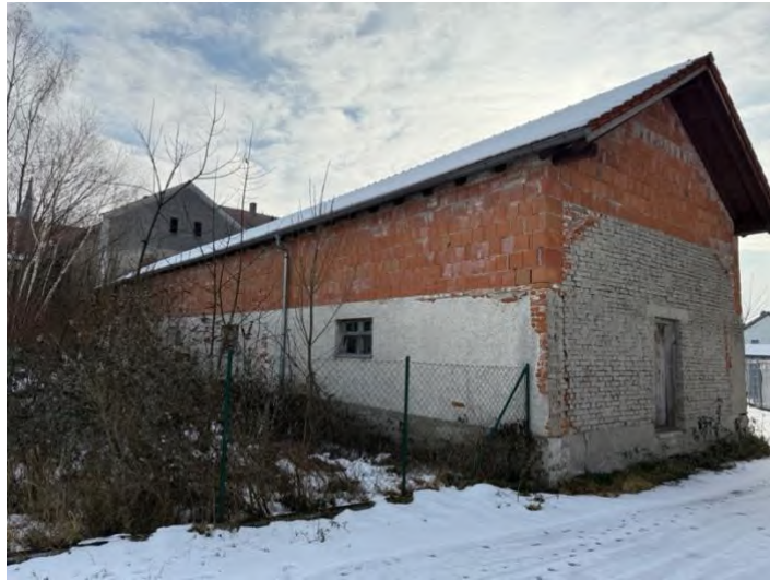
Nordwestansicht Gebäude West (ehemaliger Schweinestall)
