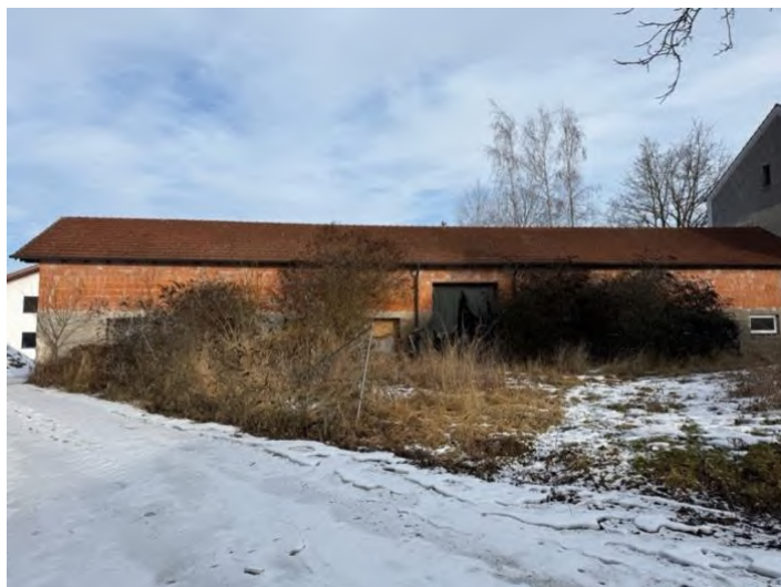
Südansicht Gebäude West (ehemaliger Schweinstall)
