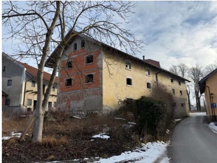
Südwestansicht Gebäude Süd
