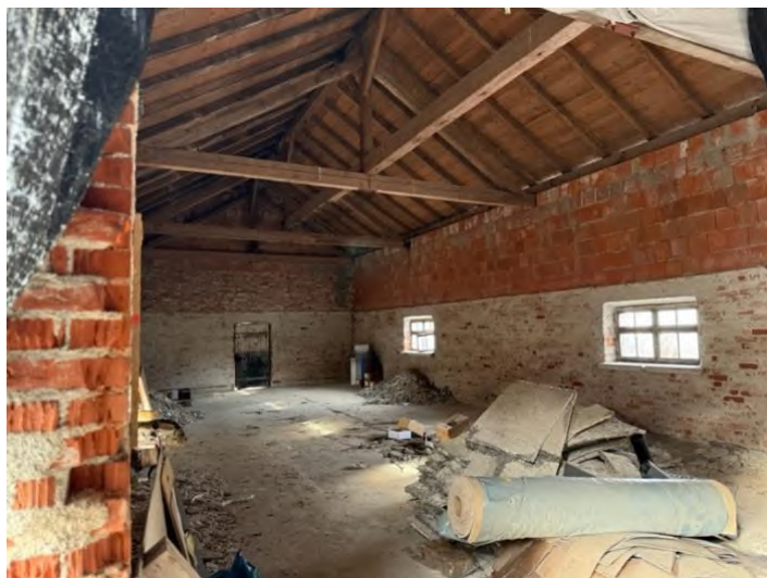
Innenaufnahme Gebäude West (ehemaliger Schweinestall)
