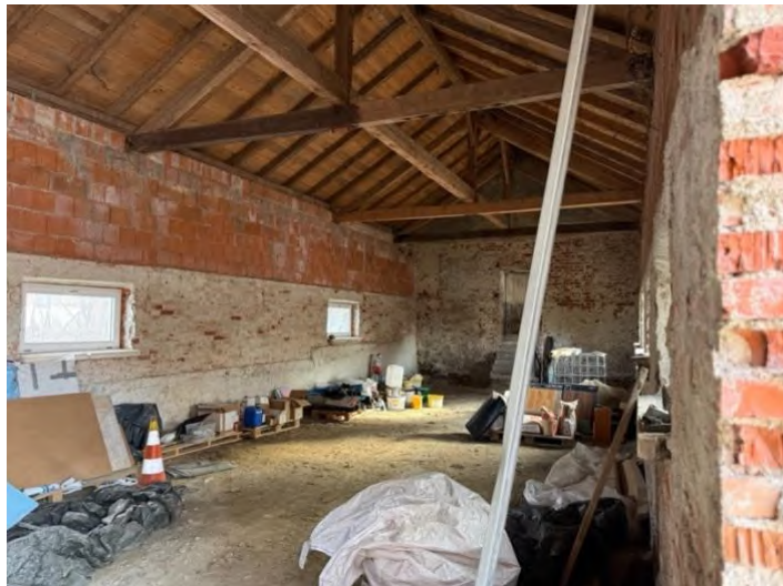
Innenaufnahme Gebäude West (ehemaliger Schweinestall)
