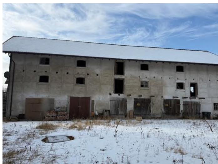
Nordansicht Gebäude Süd
