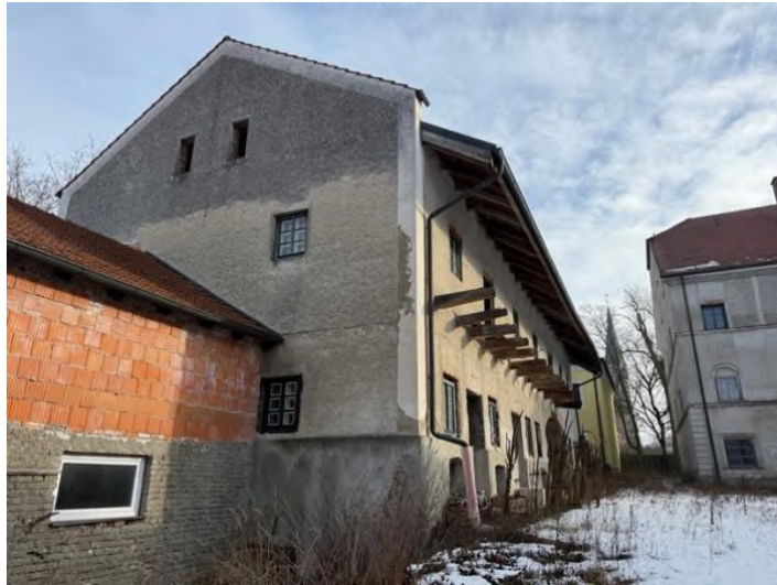
Südwestansicht Gebäude Nord
