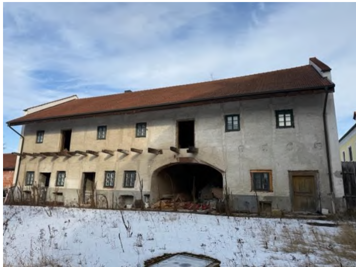
Südansicht Gebäude Nord
