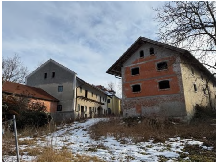
Südwestansicht Gebäude Süd und Gebäude Nord
