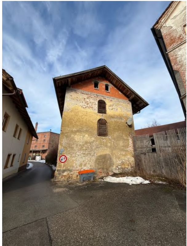
Ostansicht Gebäude Süd
