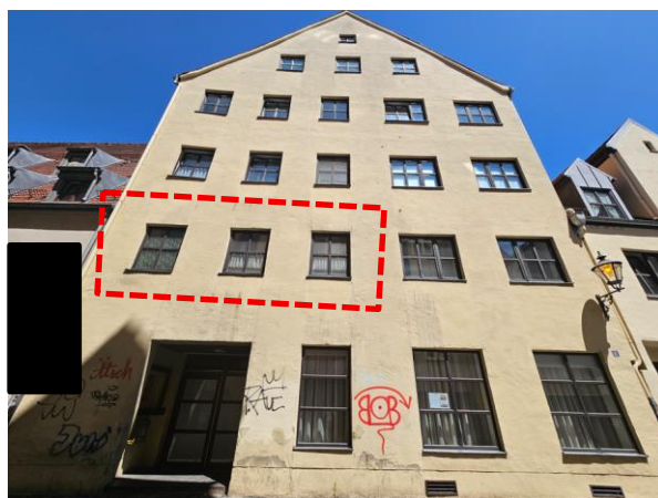
Ansicht Südwest – Altbau
