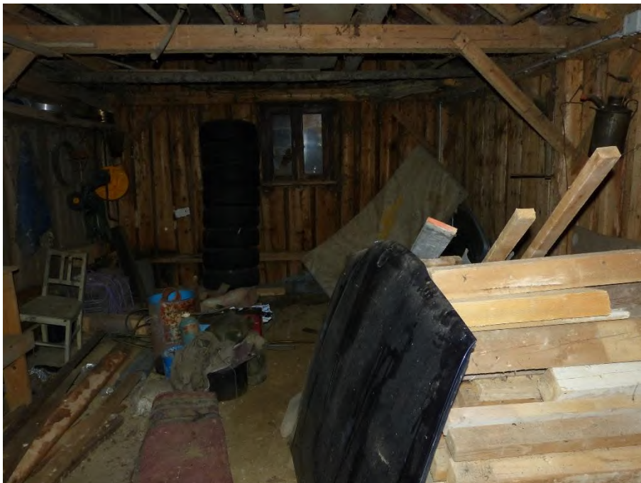
Außenanlagen, Traktorschuppen, Innenaufnahme
