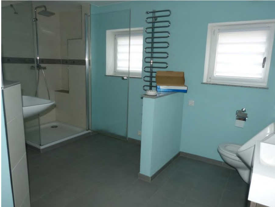
Gebäude 1: Einfamilienhaus, Innenaufnahme Bad im Erdgeschoss
