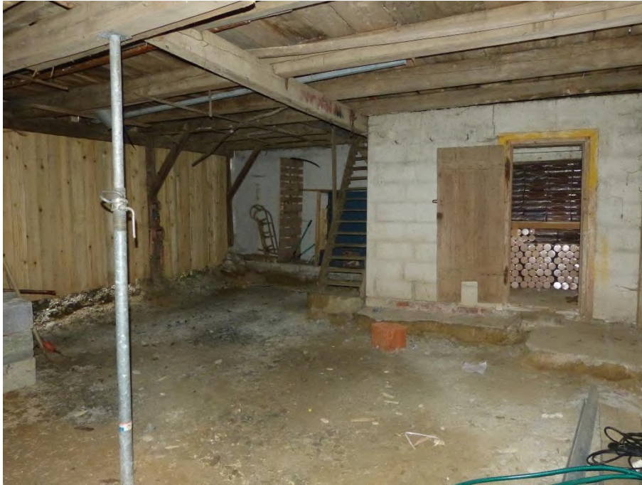
Gebäude 2: Geräteschuppen, Innenaufnahme
