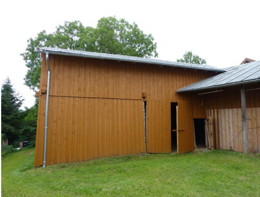
Gebäude 3: ehemalige Scheune, Ansicht von Norden
