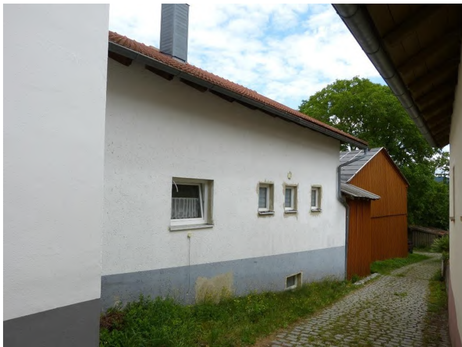
Gebäude 1+2+3: Einfamilienhaus, Geräteschuppen, ehem. Scheune, Ansicht von Nordwesten
