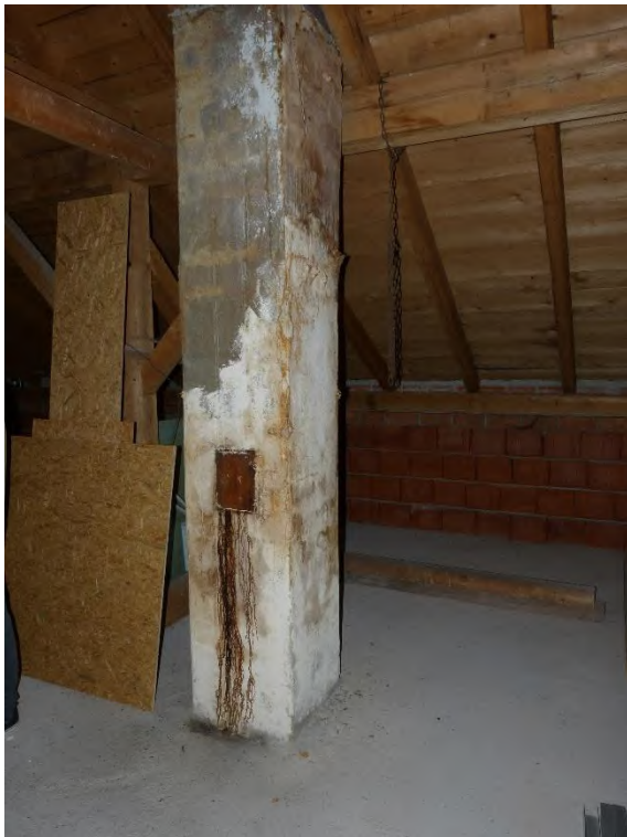
Gebäude 1: Einfamilienhaus, Innenaufnahme Schornstein mit Feuchtigkeitsschäden und Versinterungen im Dachraum
