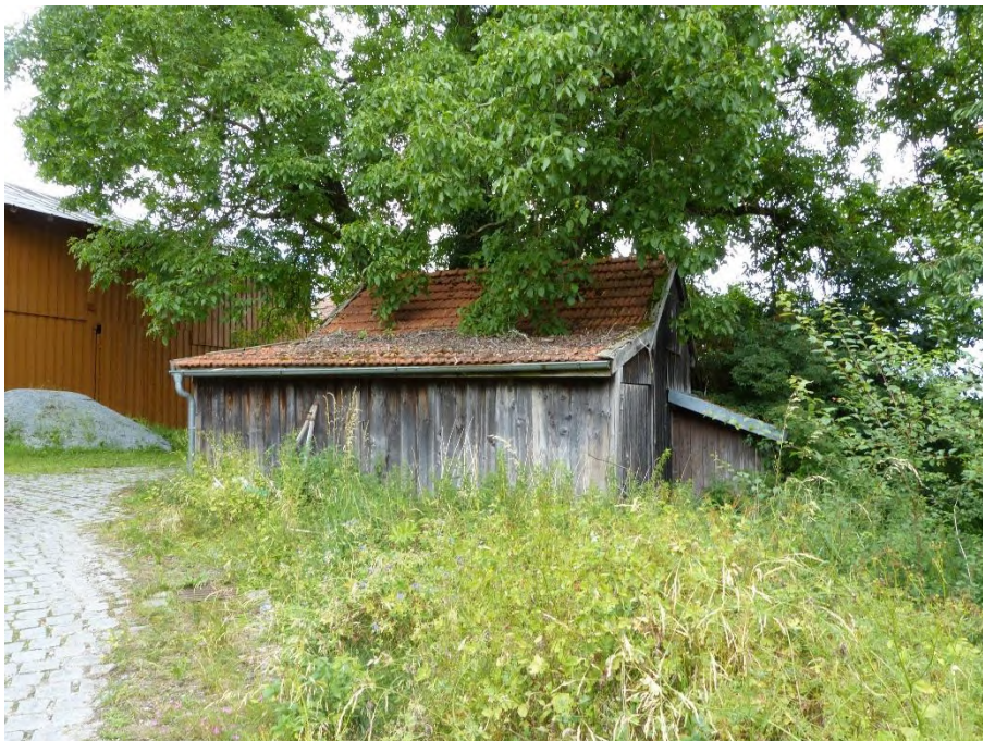
Außenanlagen, Traktorschuppen, Ansicht von Westen
