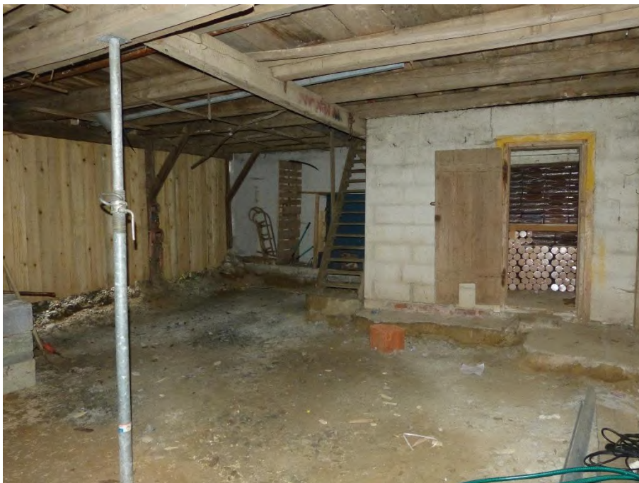
Gebäude 2: Geräteschuppen, Innenaufnahme
