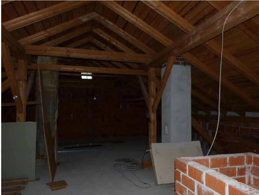
Gebäude 1: Einfamilienhaus, Innenaufnahme Dachraum
