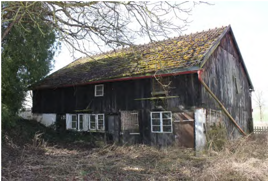
Bild 11: Nebengebäude (4) von Nordosten
