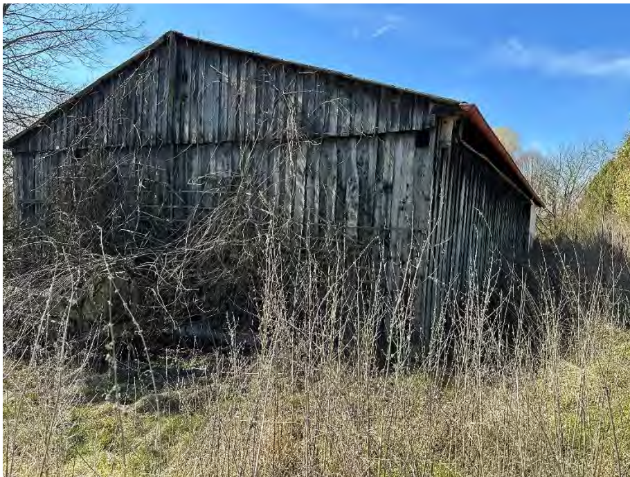
Bild 8: Nebengebäude (3) von Nordosten
