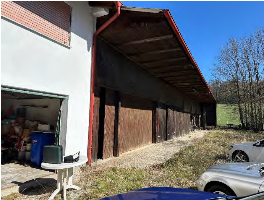
Bild 7: Nebengebäude (3) von Südwesten
