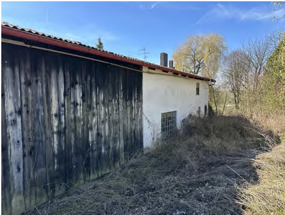
Bild 9: Nordseite des Nebengebäudes (3)
