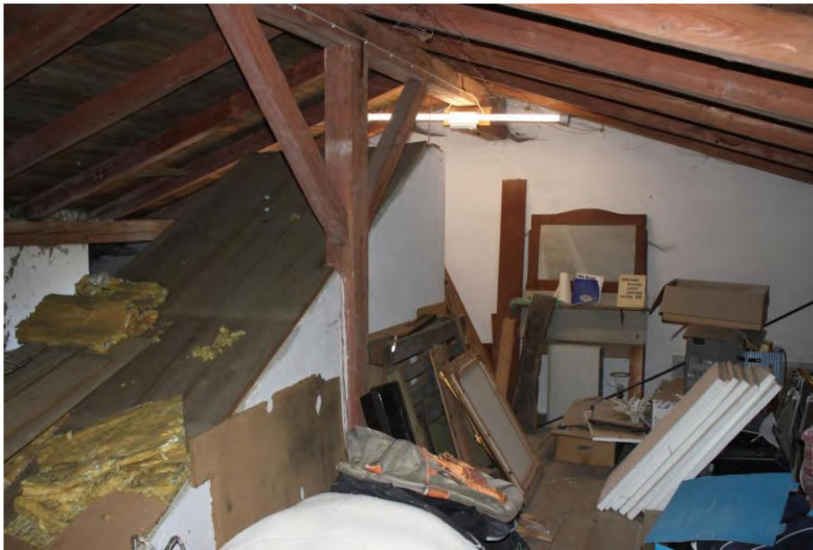
Bild 25: nicht ausgebautes Dachgeschoss
