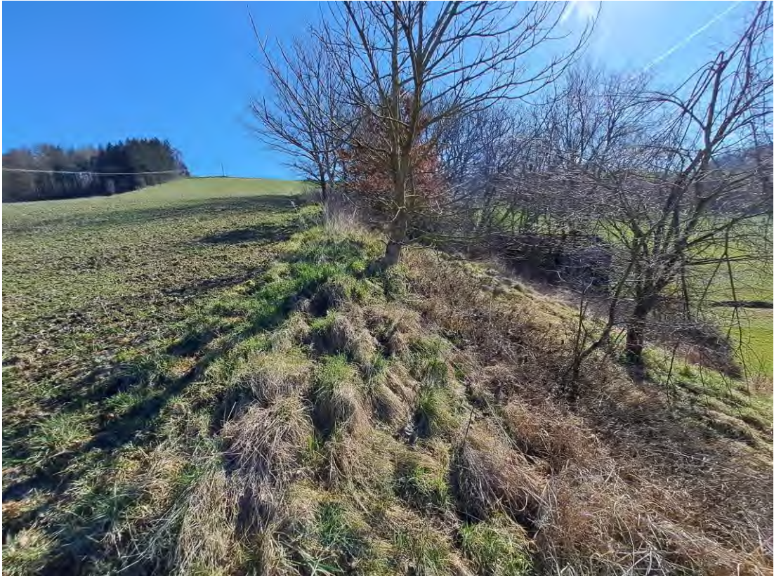
3 Flst.Nr. 1030 - Blick nach Osten - südliche Grundstücksgrenze mit Böschung
