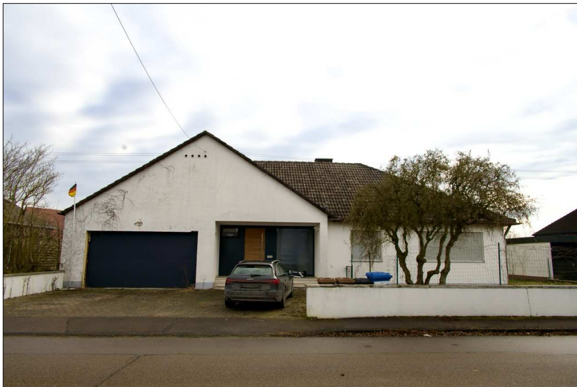
Foto 1 Straßenansicht von Westen
