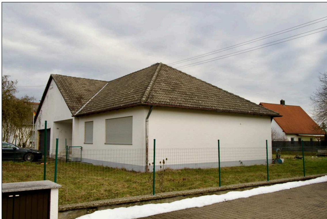
Foto 4 Ansicht von Süden
