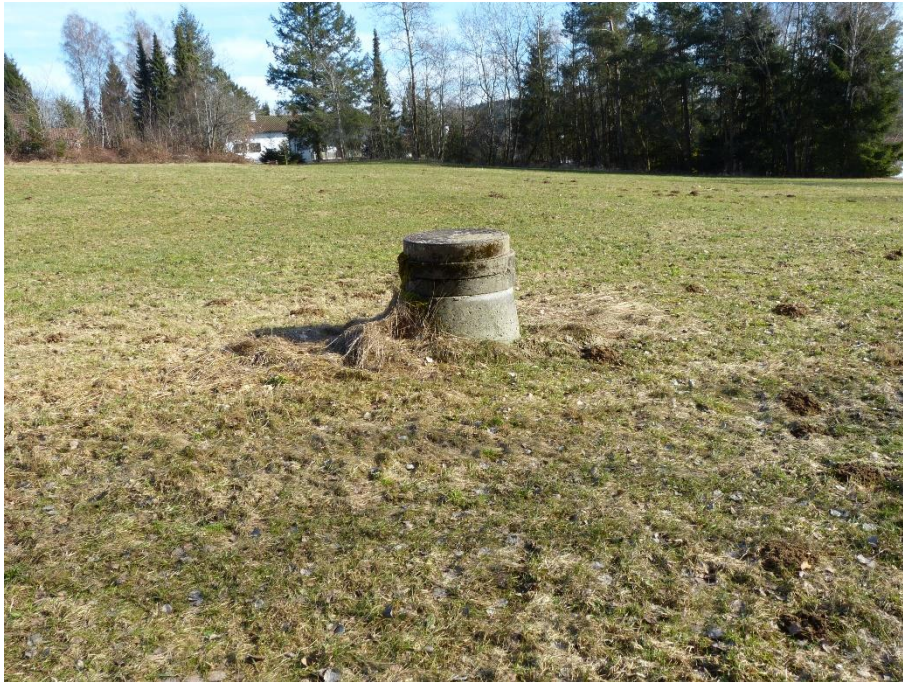
Flustück 242, bestehender Schacht auf Grundstücksfläche
