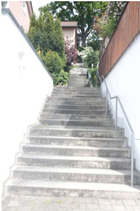
FINr. 2237/41 – Treppe zu den anliegenden Grundstücken
