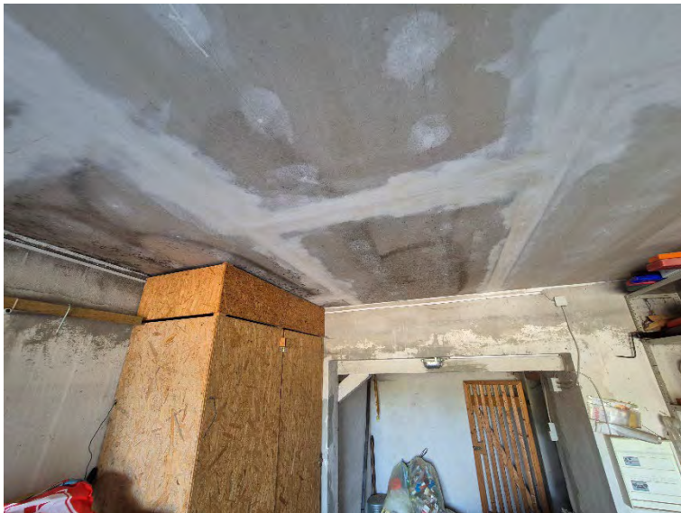
Feuchteschäden an Decke über Stellplatz 2
