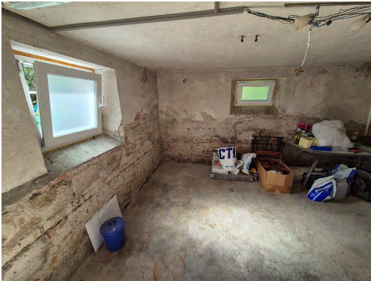
Kellerraum mit Feuchteschäden an Außenwänden
