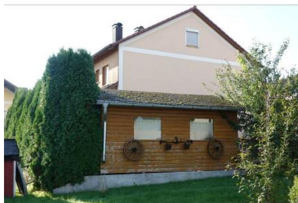
Zweifamilienhaus, Blick aus nördlicher Richtung
