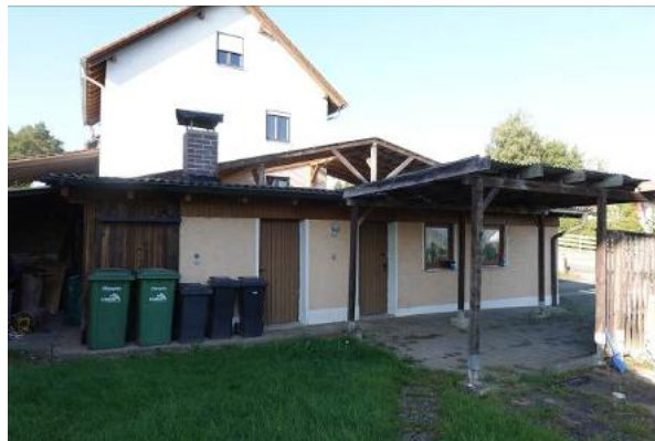
Garage mit Geräteraum, Blick aus südöstlicher Richtung
