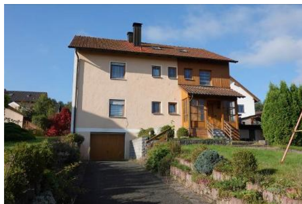
Zweifamilienhaus, Blick aus nordöstlicher Richtung
