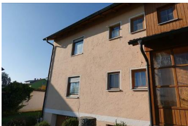
Zweifamilienhaus, Blick aus nördlicher Richtung
