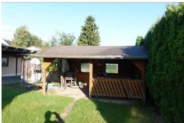
Unterstand, Blick aus südöstlicher Richtung
