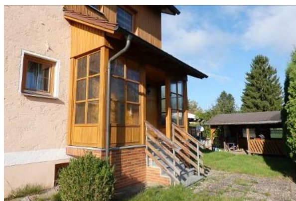
Zugang zum Hauseingang
