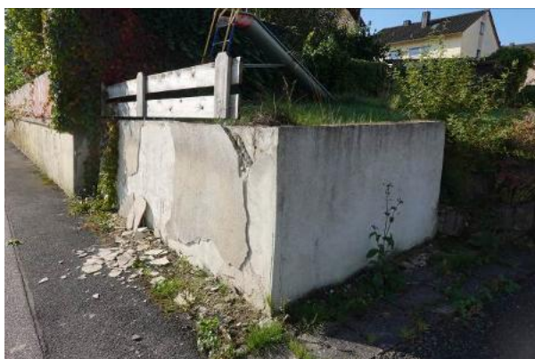
Instandsetzungsbedürftige Stützmauer
