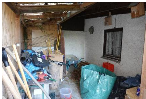
Unterstand an der Südostfassade der Garage
