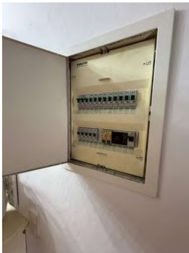
Foto 18: Unterverteiler
