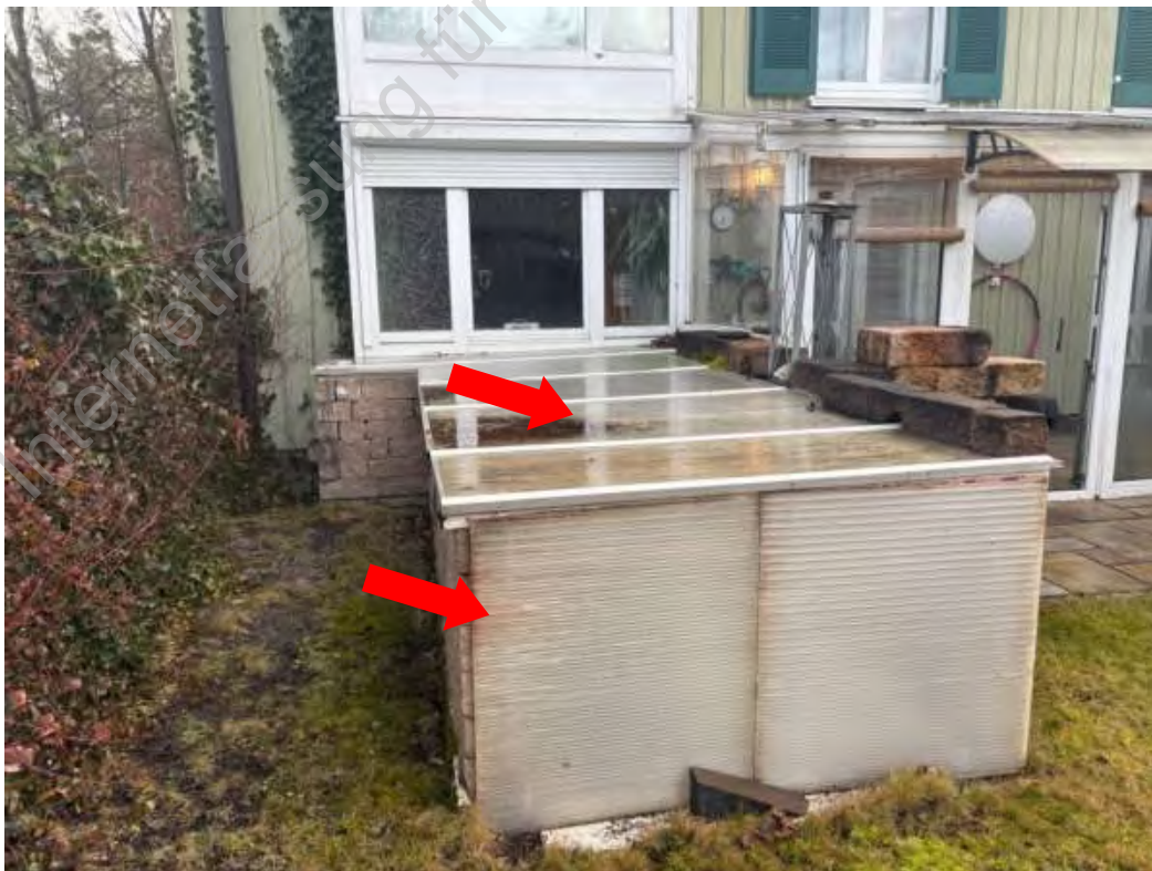
Foto 26: provisorische geschlossener Außenzugang zum Hobbyraum
