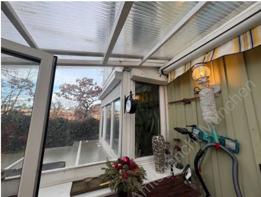
Foto 25: Blick nach Norden
