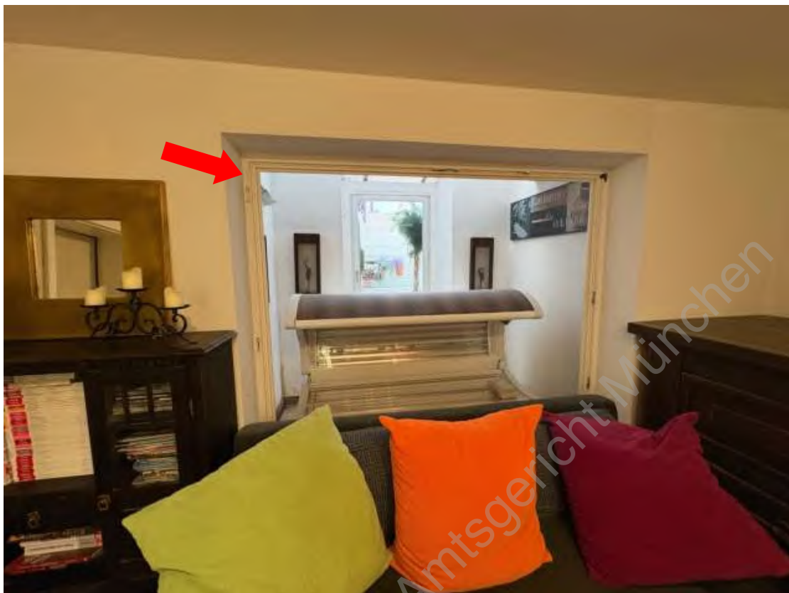
Foto 33: Hobbyraum Nr. 5, ausgehängtes Fenstertürelement
