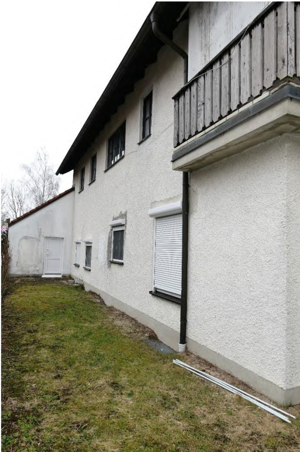
Nordwestfassade von Westen
