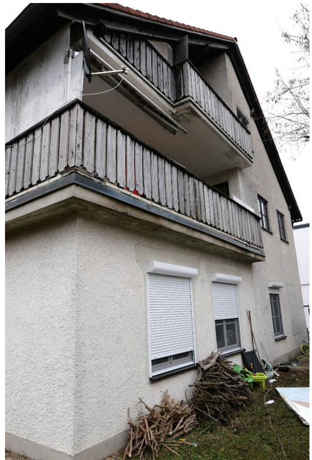
Südwestfassade von Westen
