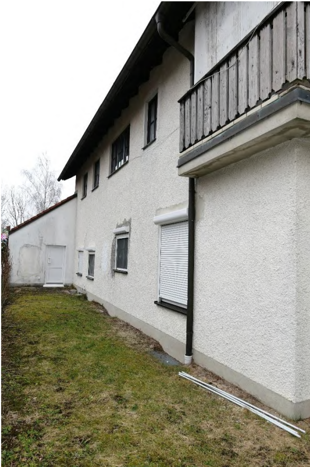
Nordwestfassade von Westen
