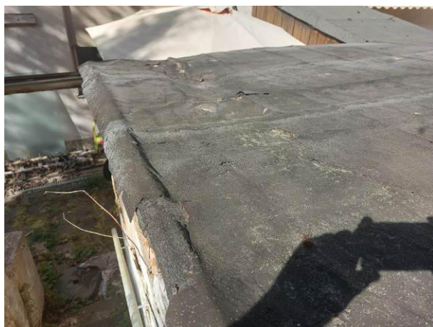
schadhafte Bitumeneindeckung
