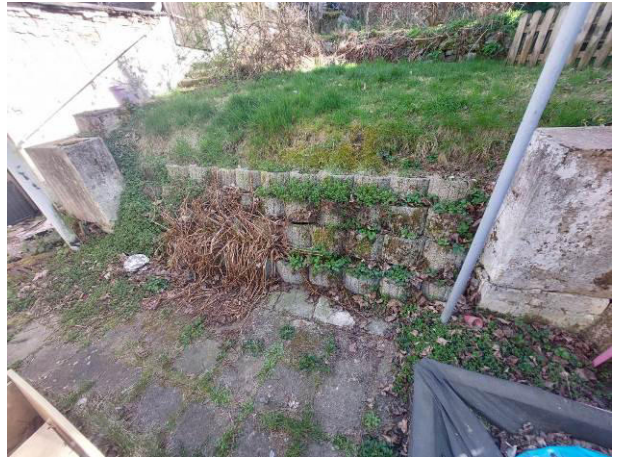
schadhafte Stützmauer
