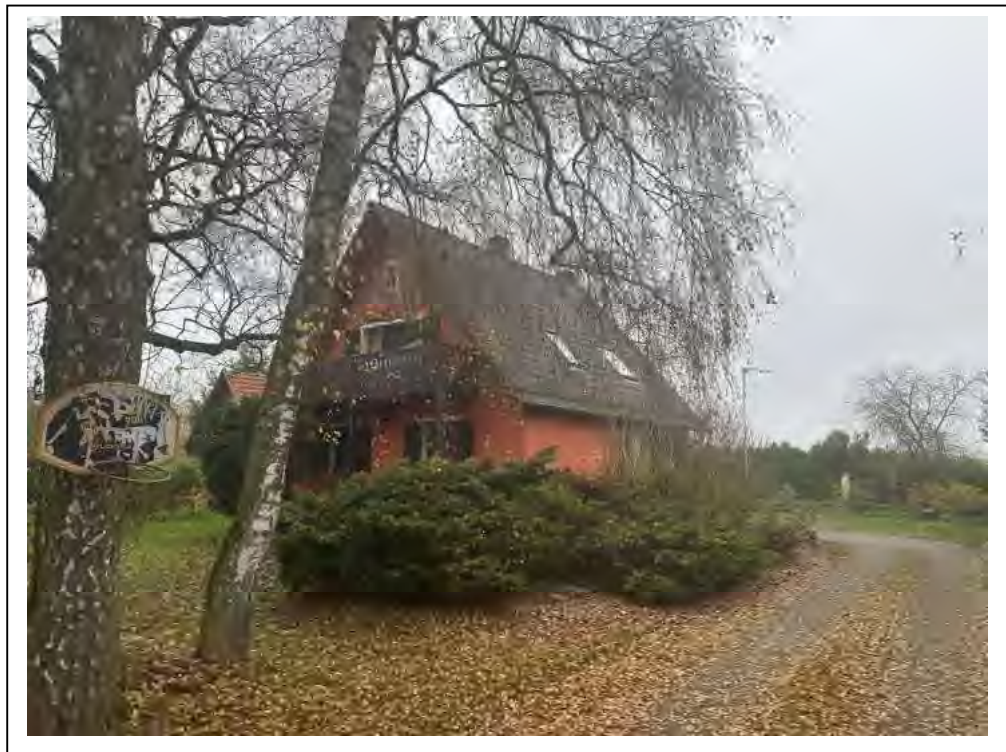
Foto 5: Wohnhaus BT 1 - Ansicht von Südosten
