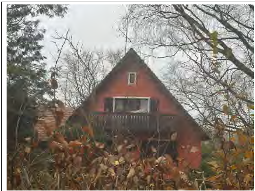
Foto 2: Wohnhaus BT 1 - Ansicht von Süden
