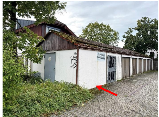
Trafostation (FISSt. Nr. 88/53)
