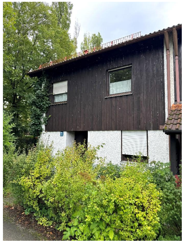
Ansicht von Norden
