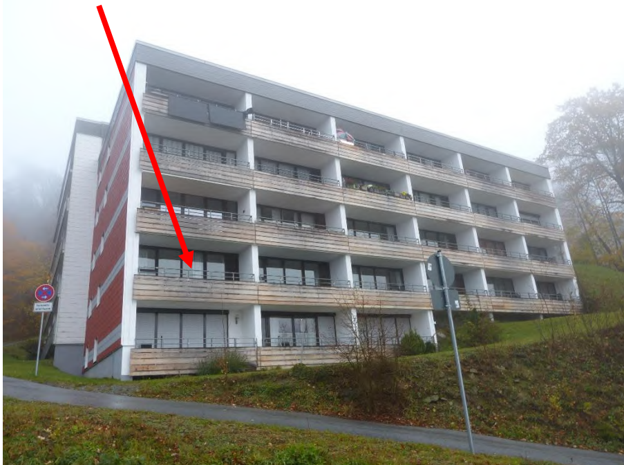
Ferienwohnanlage, Ansicht Block O von Süden
