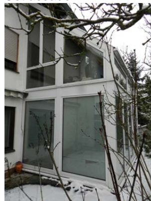
Wintergarten bei Südfassade
