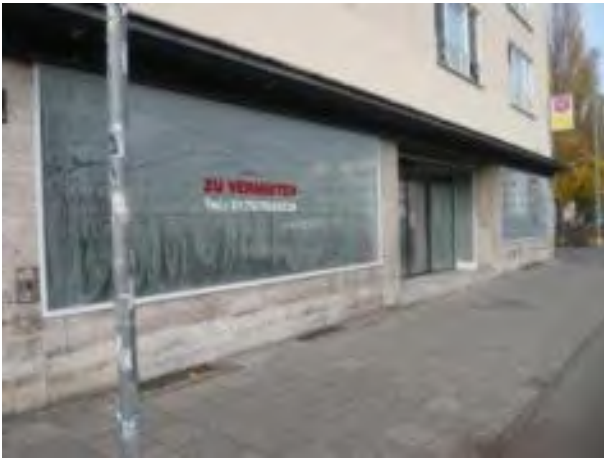
Ansicht v. Südosten
